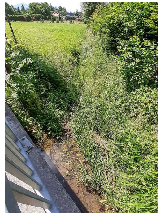
Abb. 3: Graben an der Ziegelstadelstraße im Juni 2022.
