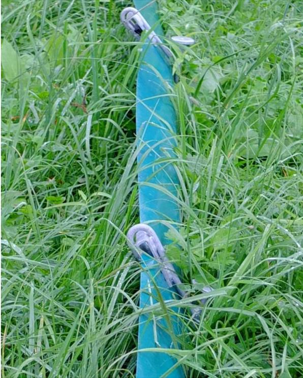
Permanente Sperrzäune oder Leit-Einrichtungen an Amphibientunneln müssen **regelmäßig** überprüft und **von Vegetation befreit** werden.
