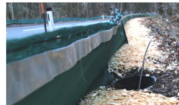
Damit Regenwasser abfließen kann, können im unteren Eimerbereich etwa 0,3 cm große Löcher gebohrt werden.
