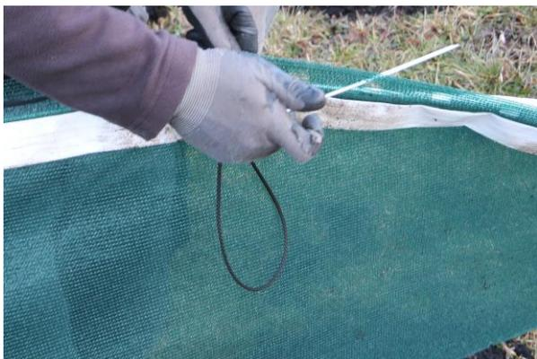
Für die Errichtung haben sich Zäune mit „Knopflochleiste“ und **Spannschnur** als besonders praktisch erwiesen, da sich diese schnell aufbauen lassen und in Bezug auf Schneedruck und Windböen unempfindlich sind.
